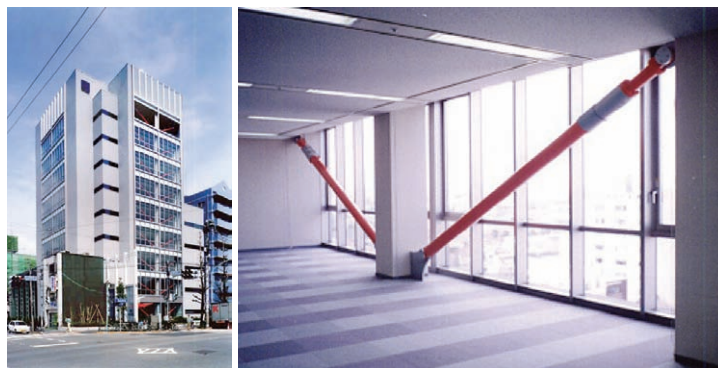
写真1 構造計画研究所本所新館とブレース型オイルダンパー
