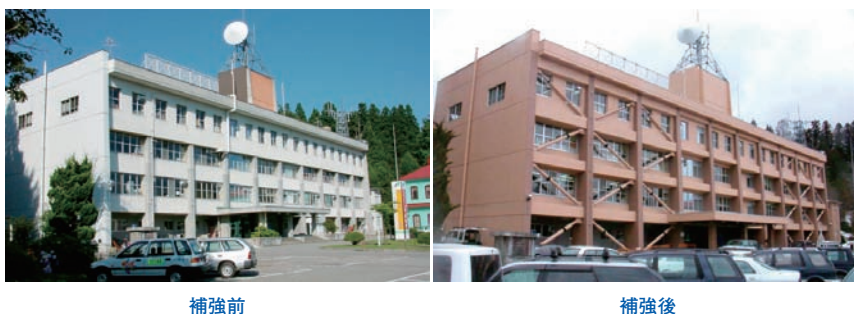
写真4 ブレース型オイルダンパーを採用した建物 会津田島庁舎
